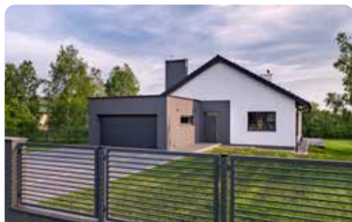
Protezione muri di cinta
